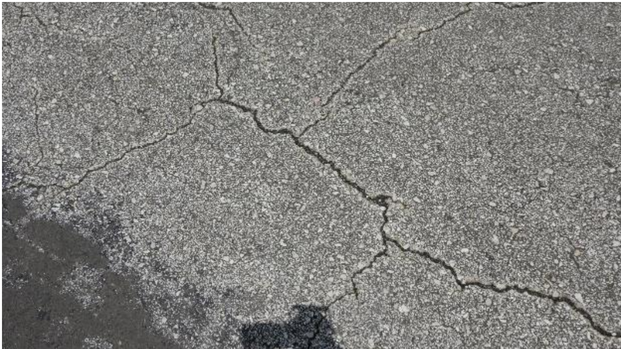
Figure 24. Apron A-1772, Close.
